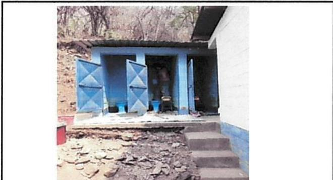
Foto 3: Reparación de baños ciegos existentes (pintura de puertas y fundición de banqueta de enfrente
